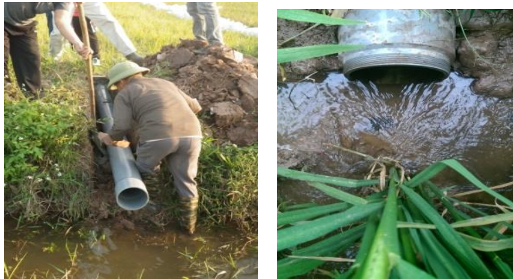
Hình A.1 - Lắp đặt ống tưới và tiêu trong các ô ruộng
