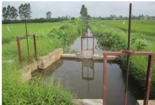
Hình A.4 – Ảnh minh họa cụm cống điều tiết tưới và tiêu
