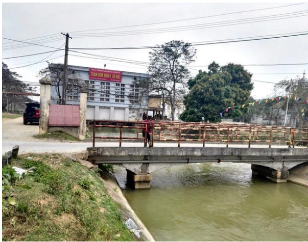
LS2 Trạm bơm Bạch Hạc
